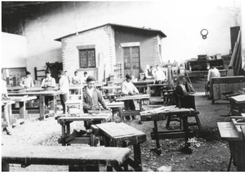
Escuela Técnica de Maestros Constructores.
